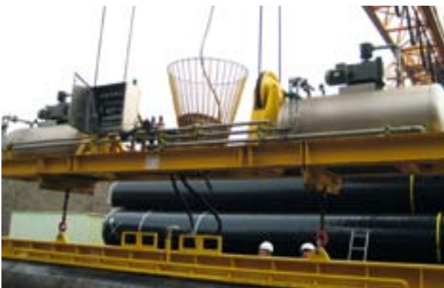
Vakuumrohrtraverse für Großrohre mit einem Durchmesser von bis zu 1.100 mm.
