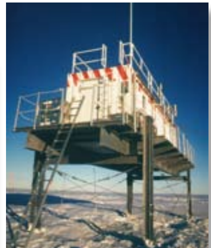
Thermisch isolierter Laborcontainer für die Neumeyer-Station in der Arktis.
