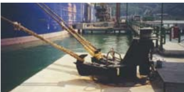
Typische 3-Hakenanlage mit integriertem Spill.
