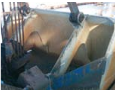
Richten und Reparatur eines Kohlegreifers.
