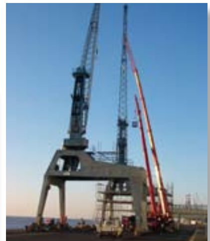
Sanierung von zwei Wippdrehkränen.
