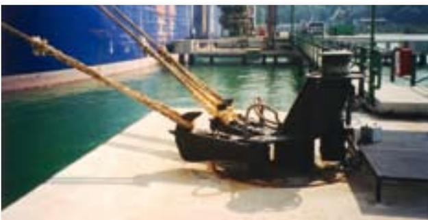
Typische 3-Hakenanlage mit integriertem Spill
