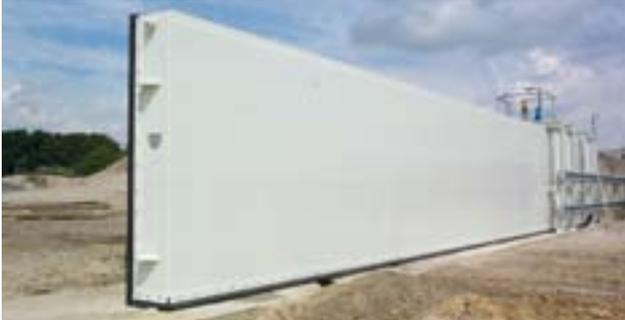
Elektrisch angetriebenes Hochwasserschutztor, Länge 23 m
